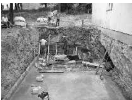
09 tu bude schodisko a výtah
