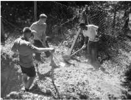
13 výkop v skalnatej pôde
