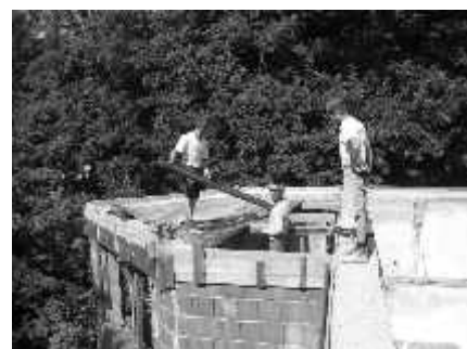
10 nadstavba nad vchodom
