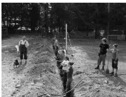
06 výkop pre novú kanalizáciu
